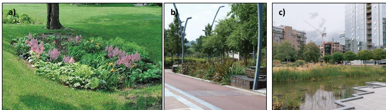
Figura 6-14: Esempi di bacini di bioritenzione in ambito privato (a) e pubblico (b e c).
