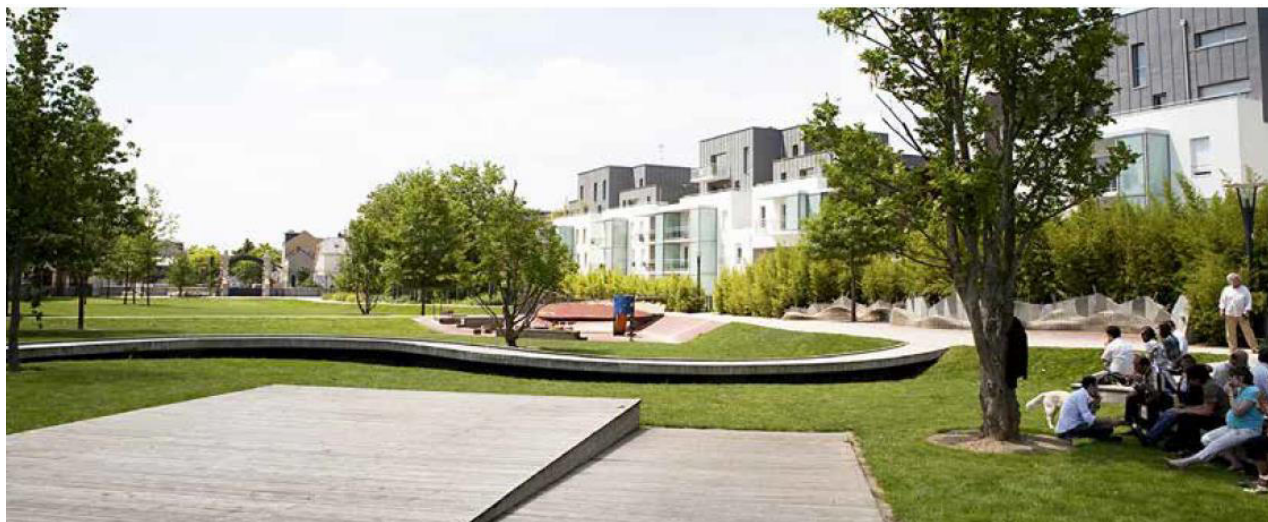
Figura 6-16: esempio di parco urbano inondabile (bacino all'interno dell'eco-quartiere Desjardins a Angers-Maine-et-Loire in Francia – Progetto paesaggistico di Phytolab - Masterplan e foto di Enet Dolowy – Urbanisme Paysage)
