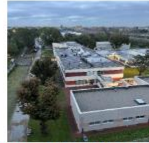
Vespucci di Milano – rifacimento coperture
