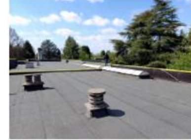
Falcone Borsellino di Arese - Coperture e impianti elettrici
