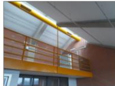
Gadda di Paderno Dugnano Infissi e risanamento ambientale
