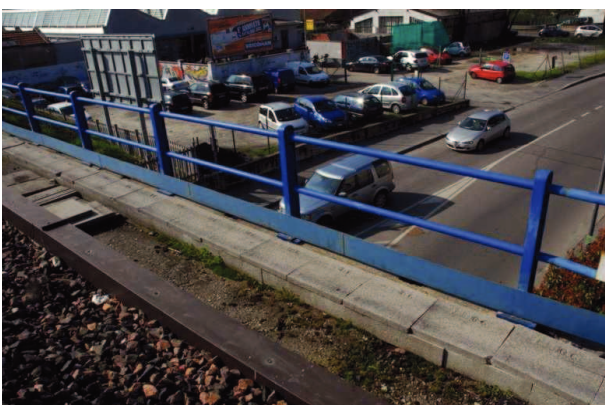
Figura 47. Sovrapasso su via Schievano – stato di fatto.
