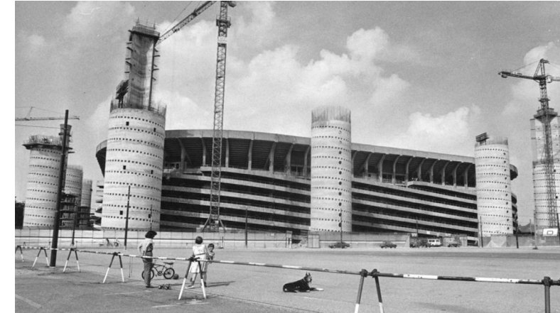
Fig. 18: La costruzione delle torri
