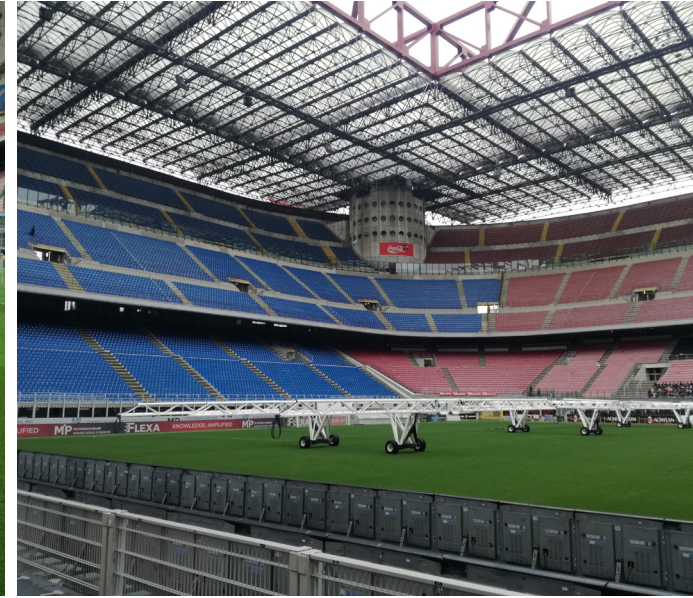
Fig. 22: La curva sud e la torre angolare di sostegno alla copertura
