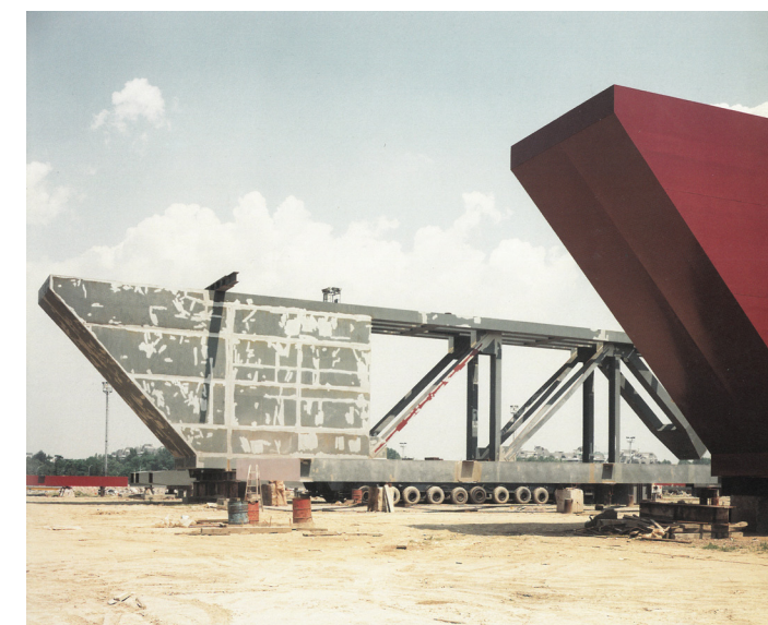
Fig. 12: Cantiere, fasi di montaggio terzo anello e copertura
