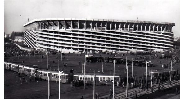
Fig. 13: vista capolinea dei tram
