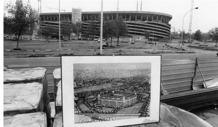
Fig. 17: L'inizio del cantiere
