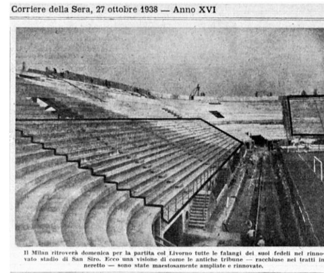
Fig. 06: Immagine dei lavori di ampliamento
