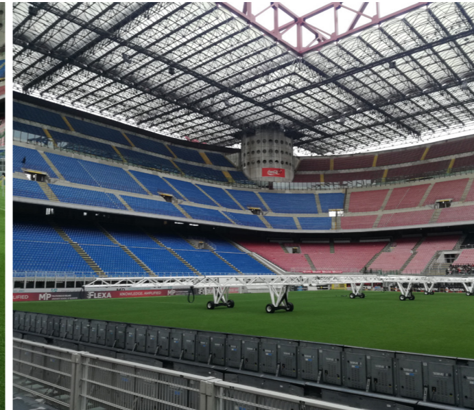
Fig. 02: La curva sud e la torre angolare di sostegno alla copertura
